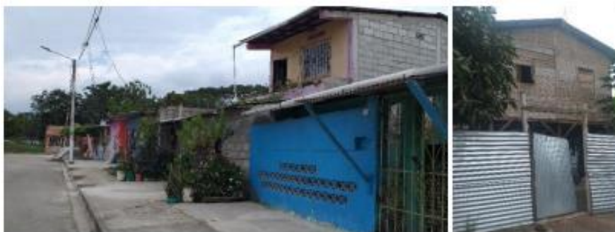
Viviendas de la Parroquia Tendales
